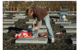
Steine schleppen (zur Befestigung der Module)
