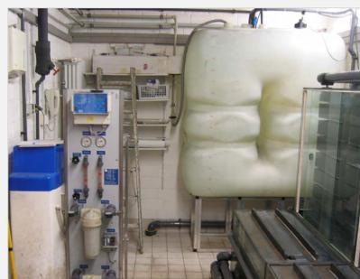
Die Umkehrosmose-Anlage für die Zuführung von Frischwasser in die Fischanlage wurde von
