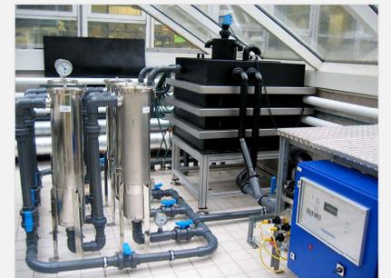
Damit konnte eine wesentliche Absenkung des Strömungswiderstandes erreicht werden. Die Minimierung der Pumpenleistung ergibt eine Einsparung von 2,85 kW und somit ca. 25.000 kWh im Jahr.
